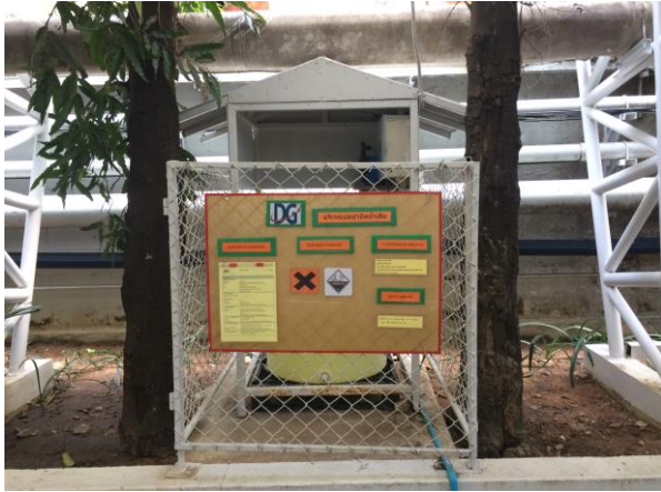
ถังเติมคลอรีนของระบบบำบัดน้ำเสียขั้นต้น ของอาคารโครงการ
