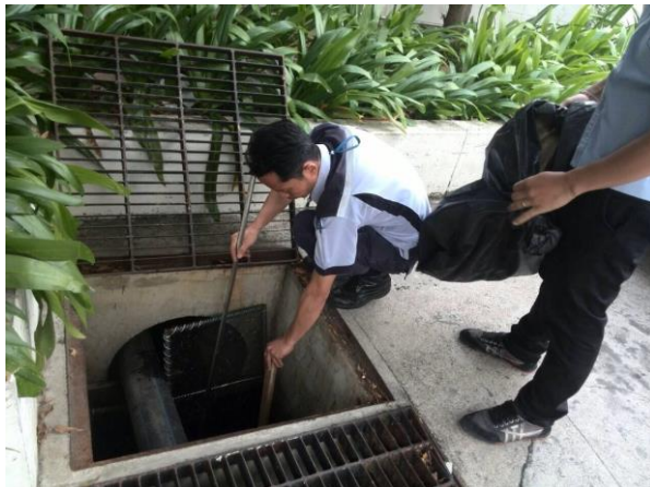
ตะแกรงดักมูลฝอยบริเวณจุดเชื่อมต่อระบบระบายน้ำของเมืองพัทยา และการตัดเศษขยะ
