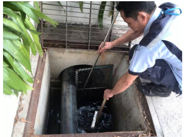
ตะแกรงดักมูลฝอยบริเวณจุดเชื่อมต่อระบบระบายน้ำของเมืองพัทยา และการตัดเศษขยะ
